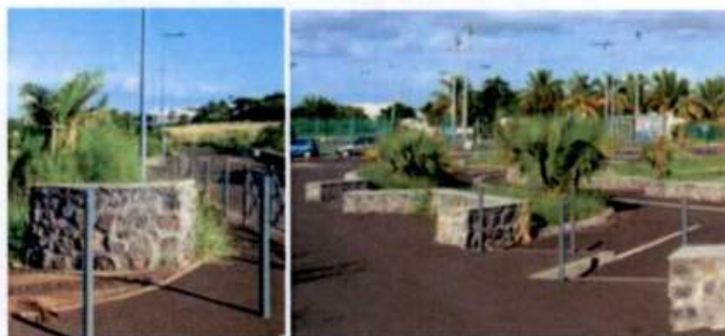
Exemple de Muret de soubassement en moellon basalte (pierre naturelle)
