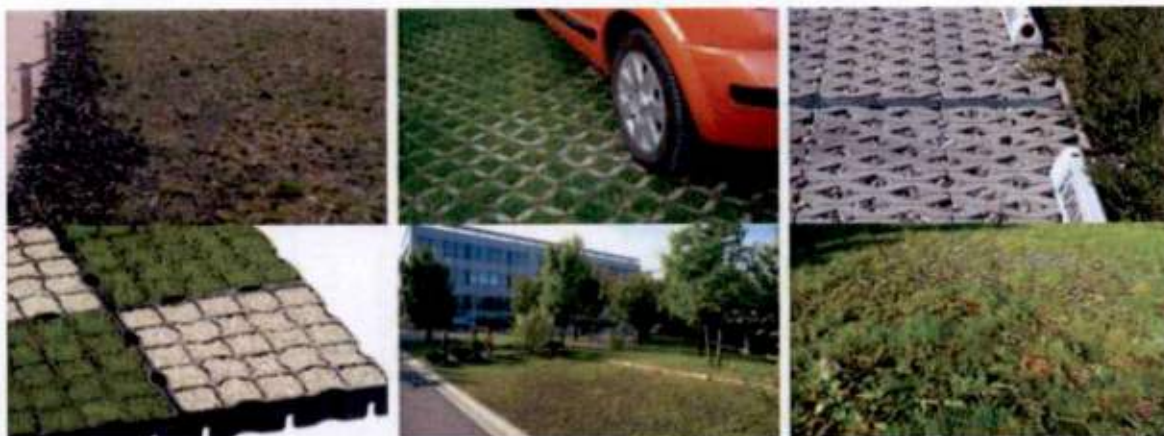
Exemples de stationnements semi-perméables : pouzzolane enherbée, dalle gazon, dalle gravier, evergreen
